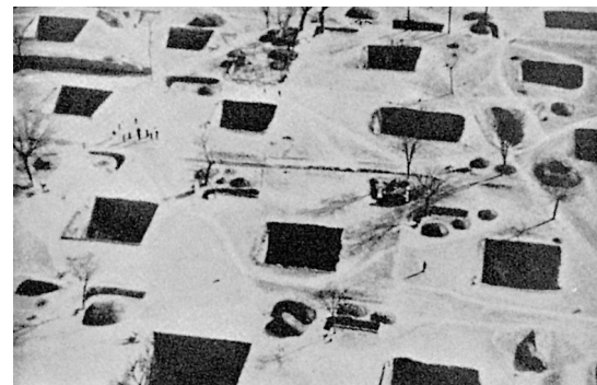
19. Asentamiento subterráneo en China.
